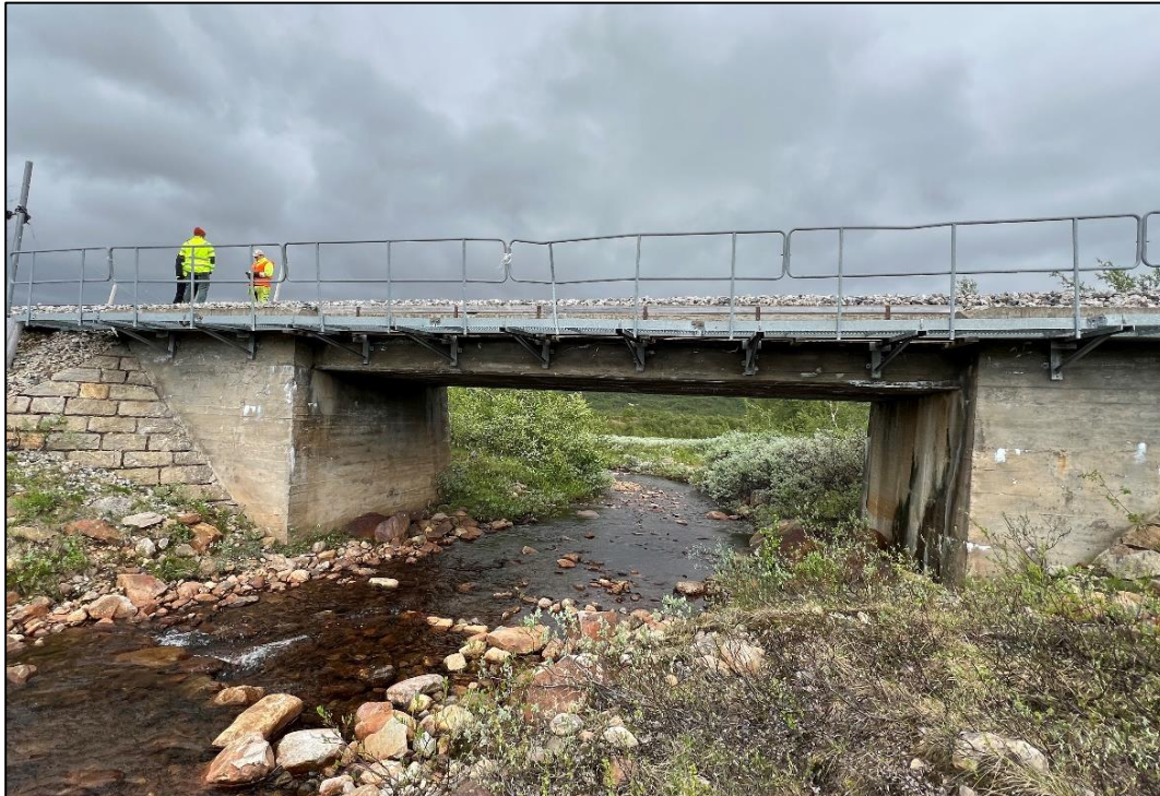
Figur 5-17 Dagens jernbanebru over Krokkelva sett fra vest mot øst (Foto: Multiconsult)
