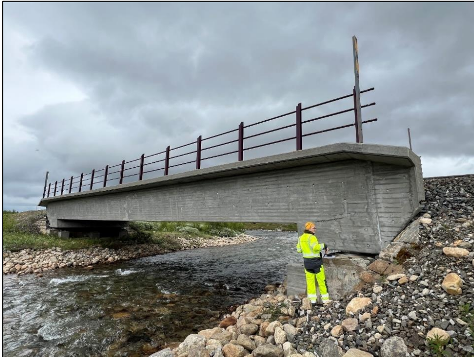
Figur 5-15 Dagens jernbanebru over Namnlauselva sett fra vest mot øst (Foto: Multiconsult)
