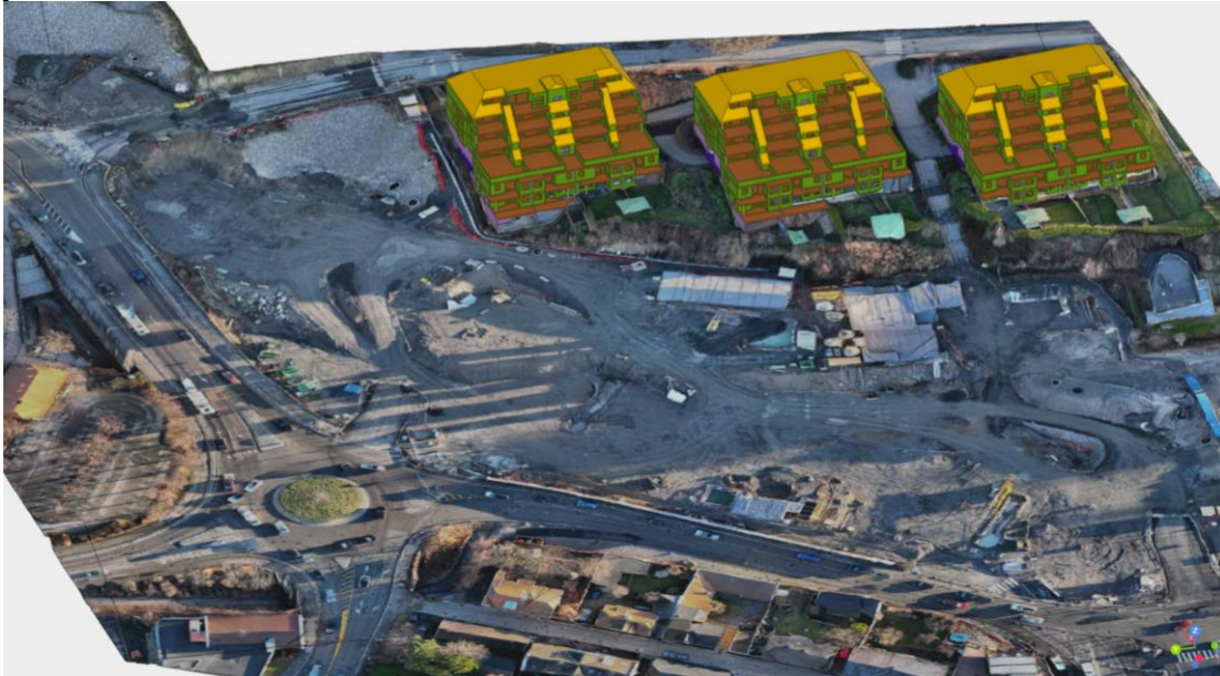
Figur 4 viser 3-d modell av Høienhaldgate nr.5, 7 og 9 i forhold til anleggsområdet januar 2025
