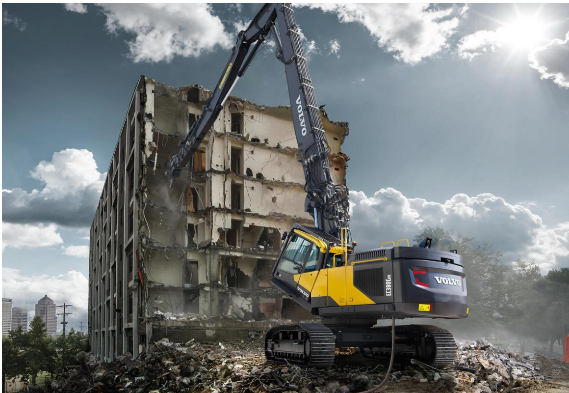
Figur 11 Illustrasjon av rivning av betongbygg (fra datablad for Volvo EC380E HR)
