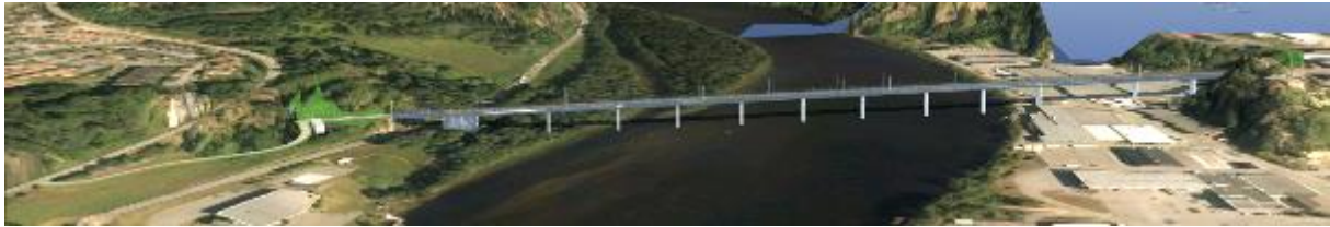
Figur 2-8 Dobbeltsporet krysser Lågen, Stålakekorridoren. Sett fra sør, retning Larvik til venstre..
