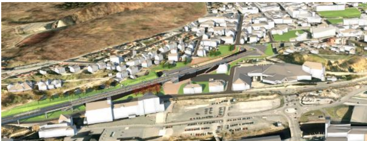
Figur 2-9 Kongegata høy sett fra Hammerdalen i sør, retning Kleivertunnelen mot venstre..
