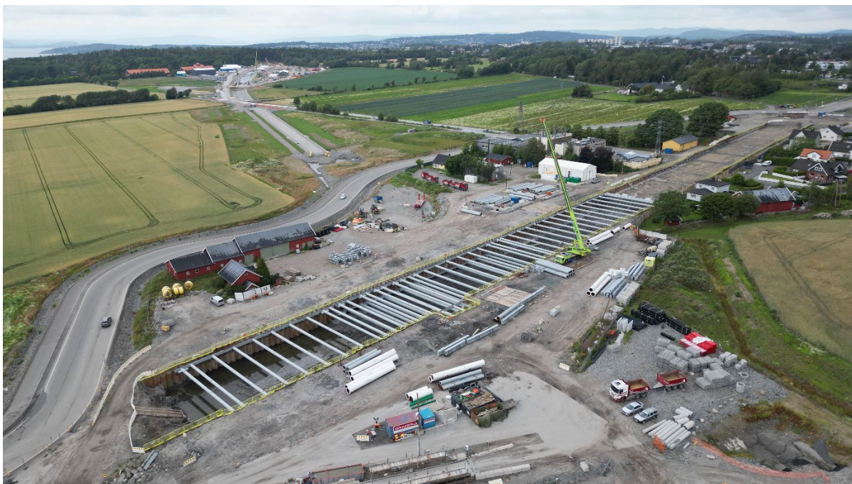
Figur 5. Stivere er montert i kulvert Larkollveien. Foto: Bane NOR.
