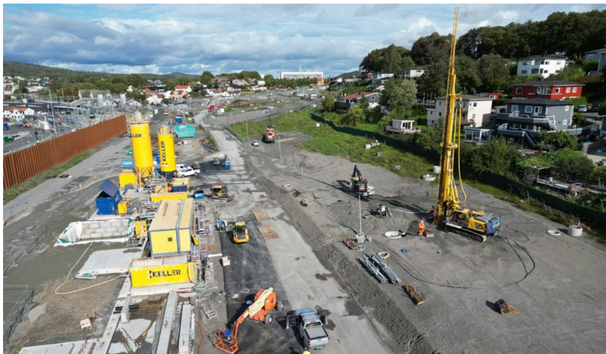
Figur 3. Jetpeling på stasjonsområdet i Moss, er et områdestabiliseringstiltak. Foto: Bane NOR.
