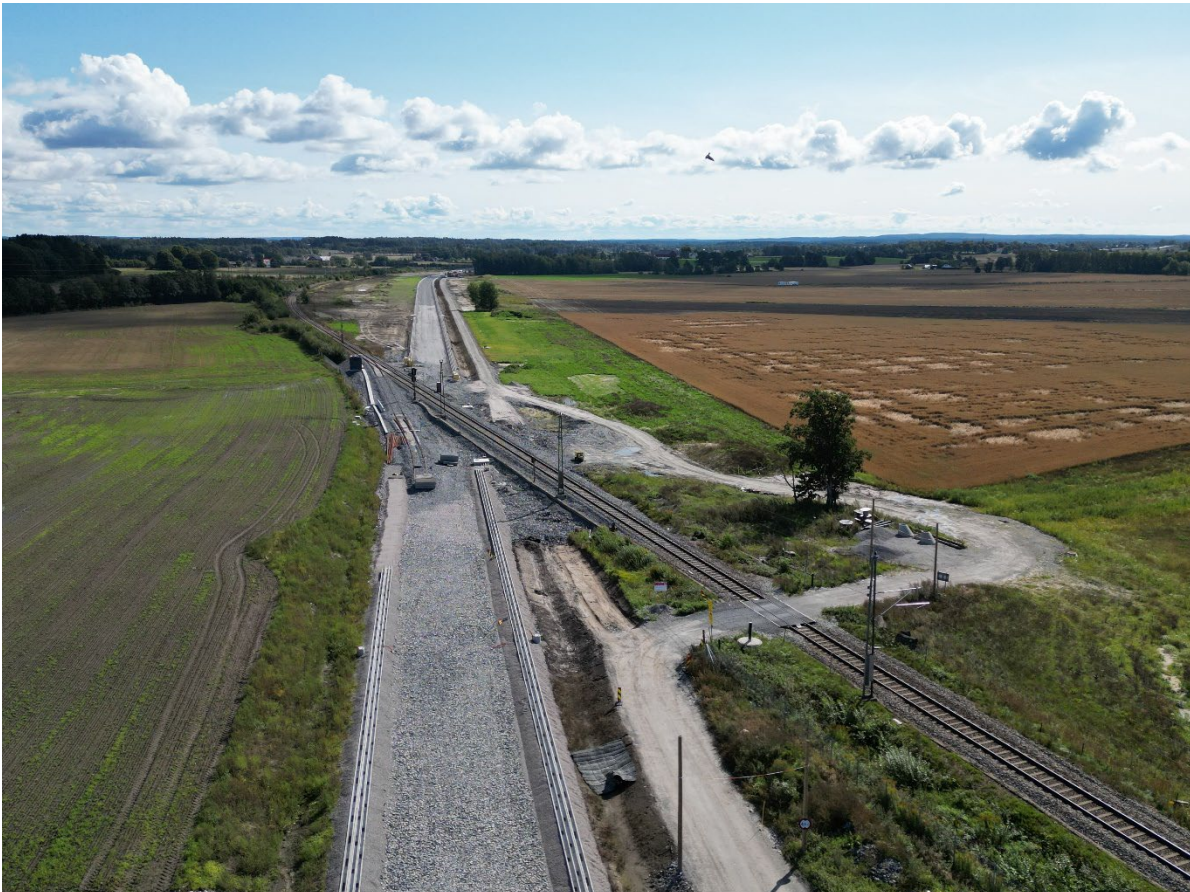
Figur 6. Drenering er utbedret og grøfter med erosjonstiltak er anlagt langs nytt dobbeltspor mellom Dilling og Såstad. Foto: Bane NOR.
