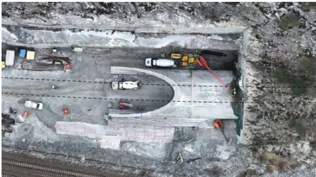
Figur 2. Ferdig støpt portal i nordlig ende av Mossetunnelen ved Sandbukta. Foto: ScanSurvey/Bane NOR
