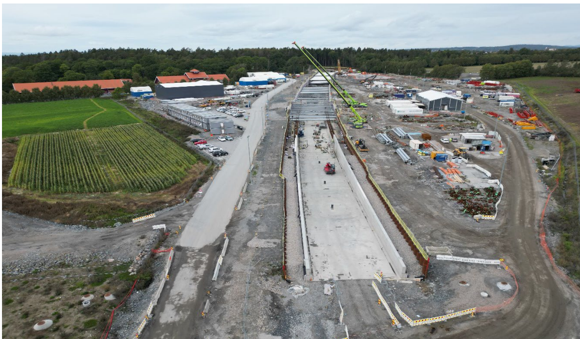
Figur 4. Kulvert Carlberg med betongstøp, sørlige del. Foto: Bane NOR.
