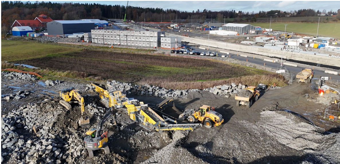
Figur 5. Anleggsområdet ved Carlberg gård, med kulvert inn mot Carlbergtunnelen. Knusing av stein i forgrunnen. Foto: Bane NOR 2025.
