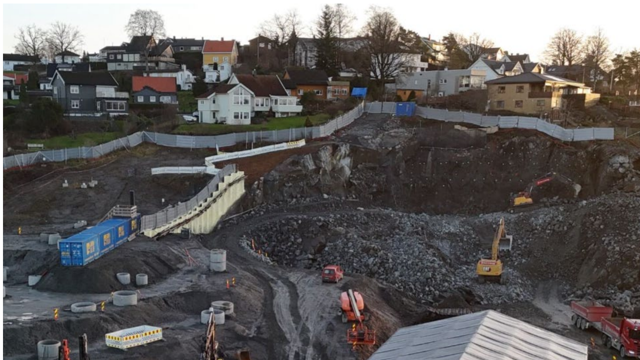
Figur 18. Ved Kleberget har vi satt opp blå containere for støyskjerming mot øst, og montert støydempende matter på toppen av spunten i forlengelsen av dette. På faste anleggsgjerder har vi hengt opp støyabsorberende matter. Bildet viser forskjæring for tunnel som er under etablering. Foto: Bane NOR (2025).
