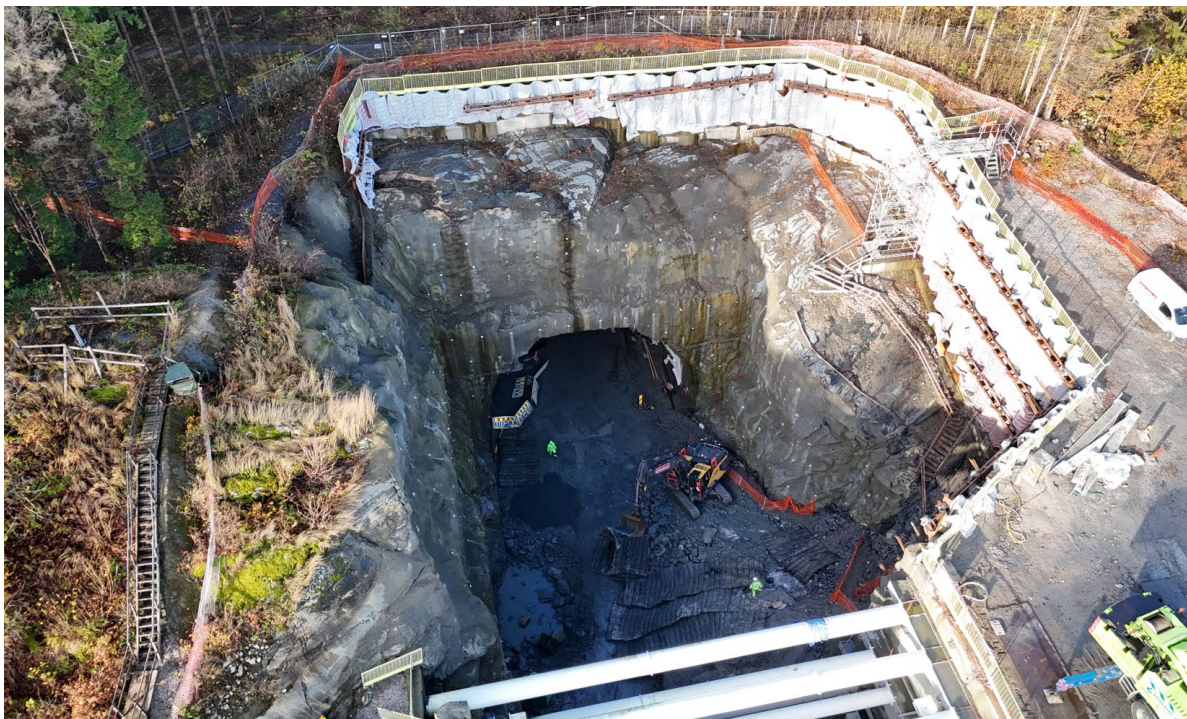
Figur 6. Carlberg kulvert og koblingen mot Carlbergtunnelen. Foto: Bane NOR 2025.
