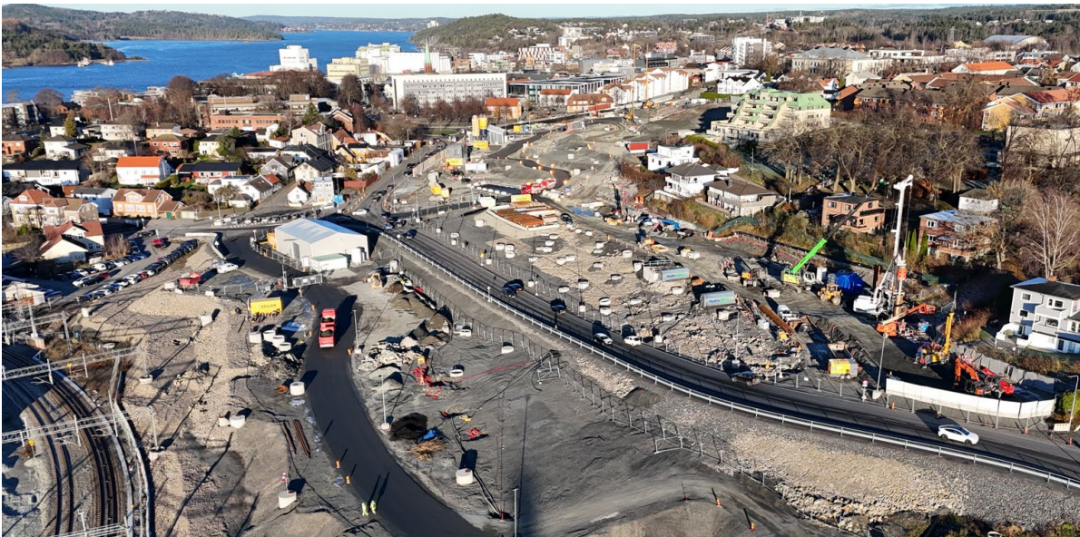
Figur 4. Anleggsområde Kransen ved Fjordveien, med boring av pilarer til høyre og vannrenseanlegget (hvitt telt) til venstre. Foto: Bane NOR 2025
