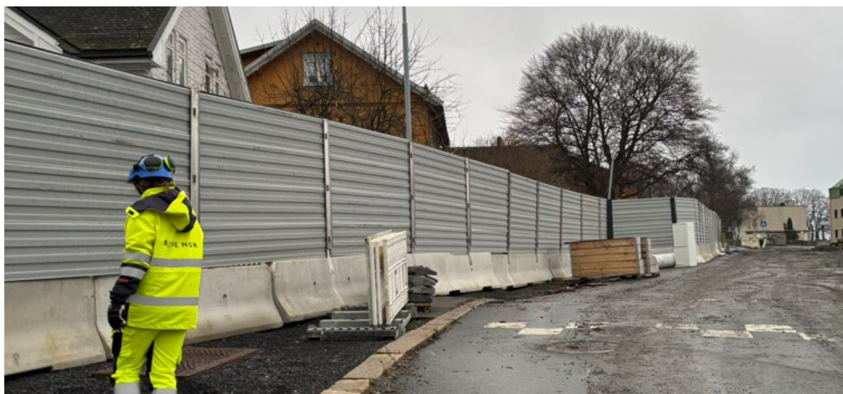
Figur 17. Støyskjermer ved riveområdet i Høienhaldgata. Foto: Bane NOR (2025).
