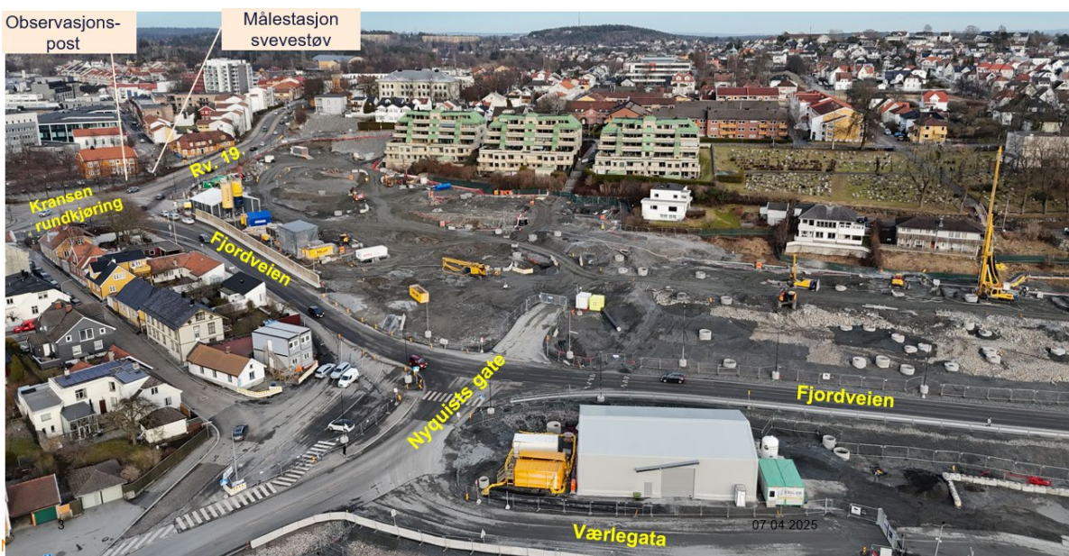
Figur 13. Observasjonspost, Kransen målestasjon for svevestøv, anleggsområde Kransen og offentlige veier. Foto: Bane NOR (2025).
