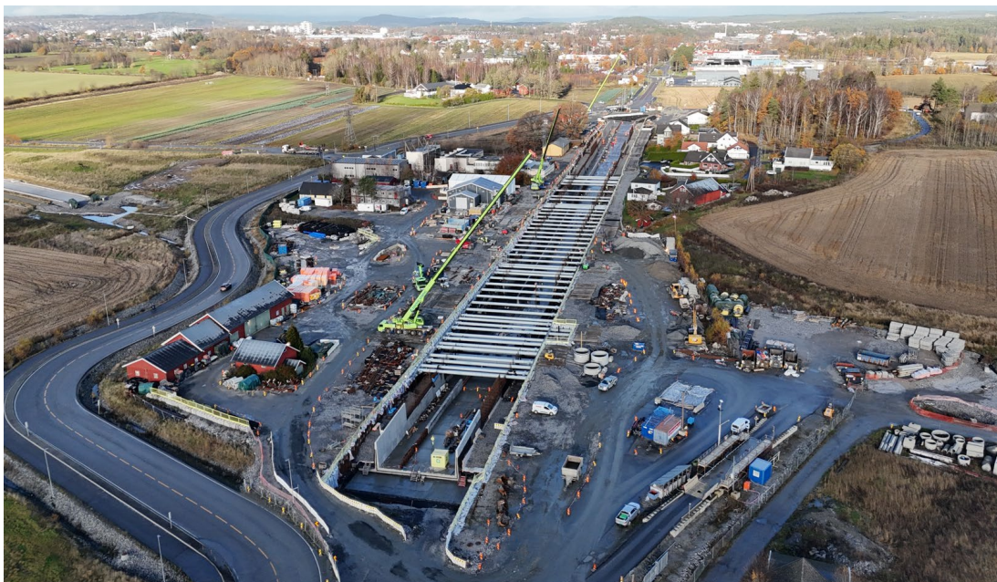
Figur 7. Veikulvert Larkollveien ved Dilling. Foto: Bane NOR 2025.
