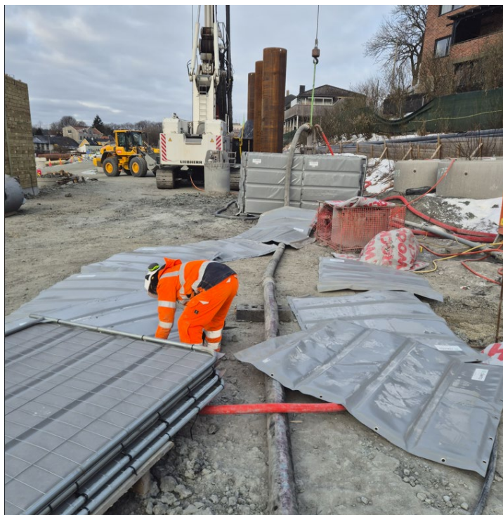
Figur 16. Støydempende matter monteres på mobile anleggsgjerder, som settes omkring pumper, og kan brukes for å dekke til pumpeledninger. Foto: Bane NOR (2025).
