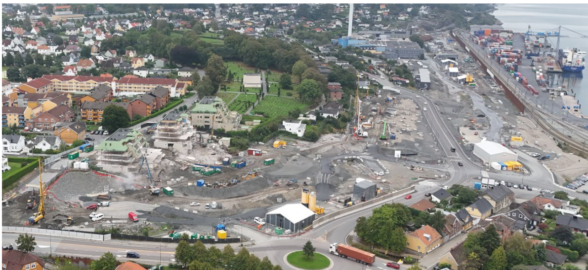
Figur 3. Jetpeling i Kransen Nord, riving av blokker og boring av pilarer ved Fjordveien. Foto: Bane NOR 2025.
