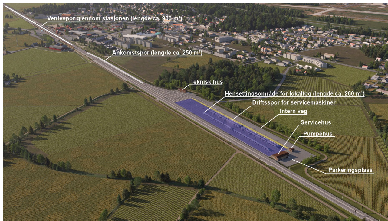
Figur 7 Oversiktsbilde som viser sentrale funksjoner på hensettingsanlegget. 1) lengder er oppgitt som tilgjengelig sporenlengde for tog.
