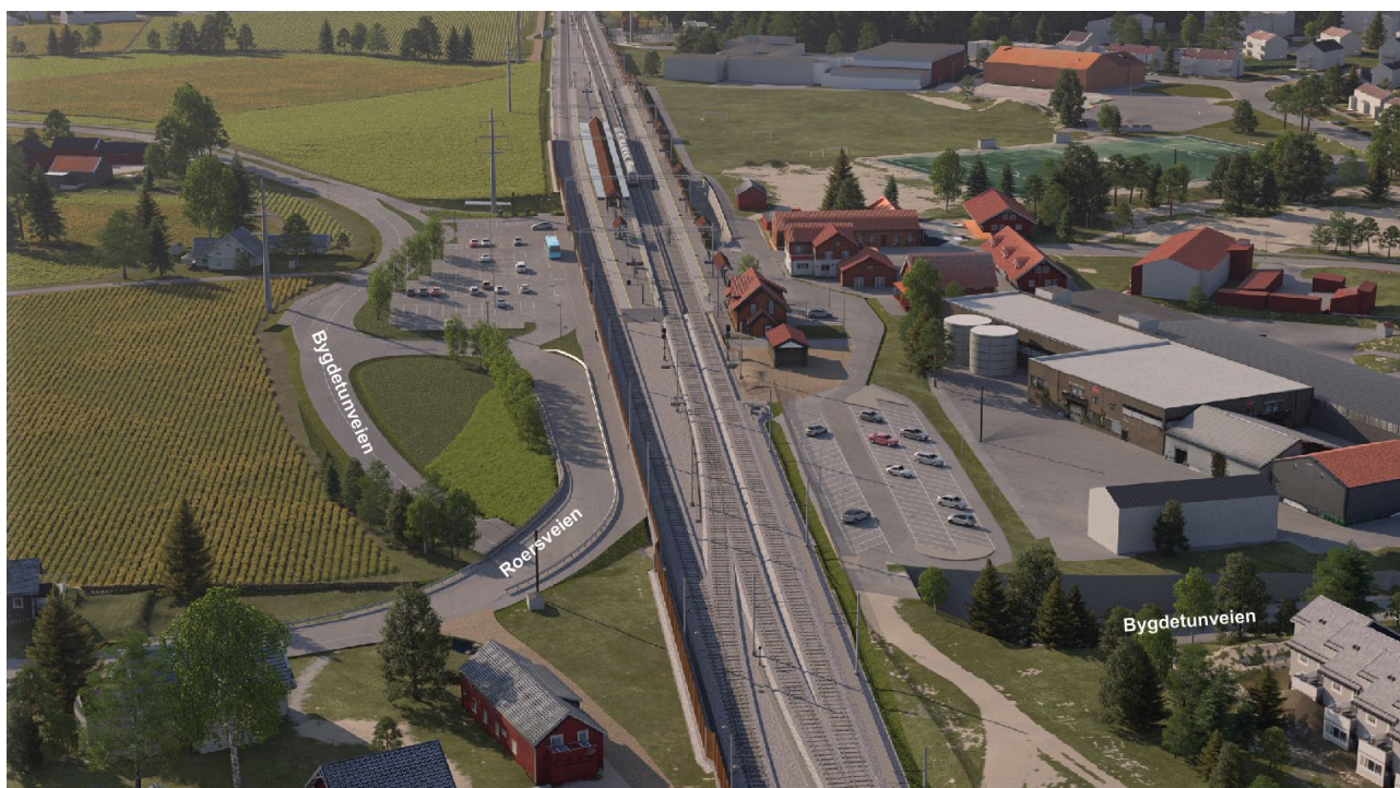
Figur 31 Oversikt over veg- og parkering sørvest for stasjonen, med Gate gård i forgrunnen. Fortau langs Roersveien, mellom parkeringsplassen og jernbanen er vist i figuren.
