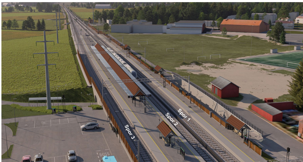
Figur 1 Oversiktsbilde fra stasjonsområde mot nordvest, retning Moss.
