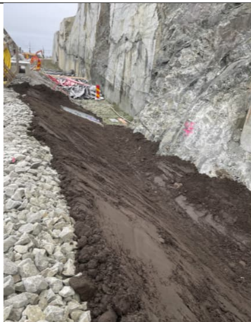
Bilde 5. Tilbakefylling av jord langs ny jernbanetrase
