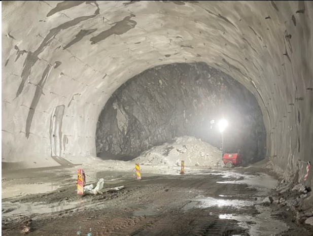
Bilde 8. Avretning i Moss tunnel
