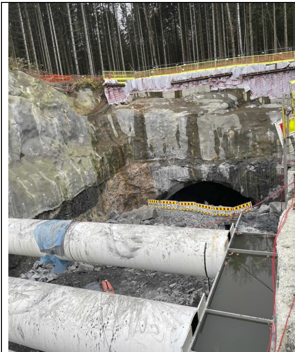
Bilde 12. Portalområdet ved Carlberg med gjennomslag til Carlberg tunnel
