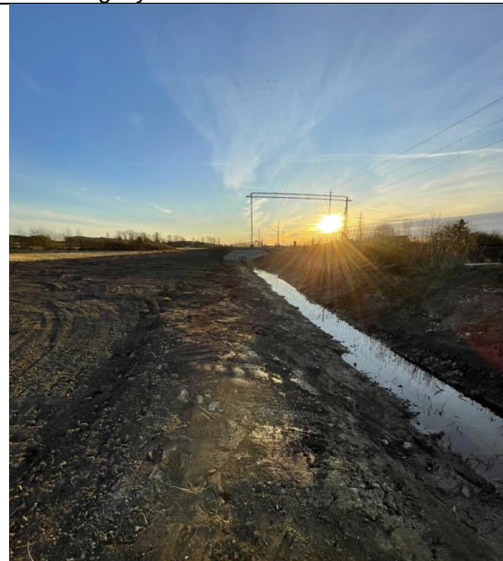
Bilde 19. Ferdigstilt mottfylling arbeid
