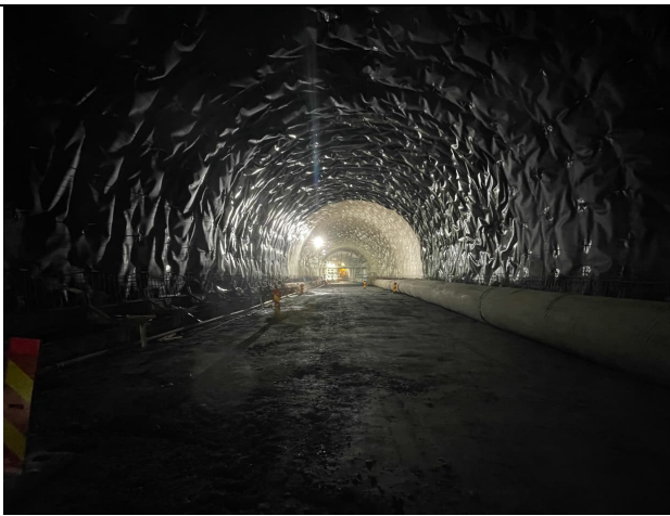
Bilde 10. og 11. Montering av membran i Carlbergtunnelen
