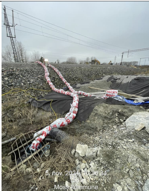
Bilde 18. System for bypassing av vannet under mottfylling arbeid
