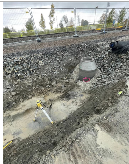
Bilde 17. Installasjon av et nytt dreneringssystem
