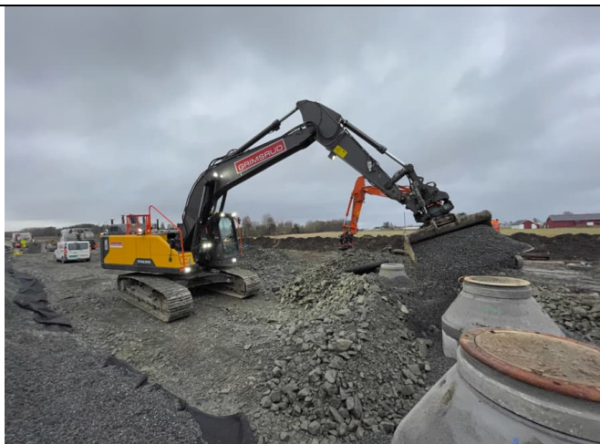
Bilde 16. Grave og dreneringsarbeid ved Såstad
