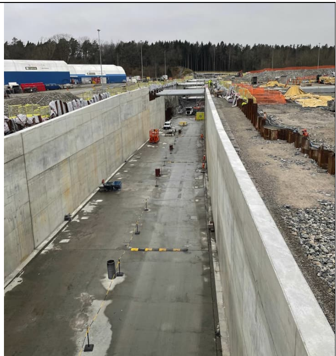
Bilde 13. Konstruksjon av kulvert ved Carlberg. Grave- og betongarbeidet var hovedaktiviteter i den delen av prosjektet i 2024
