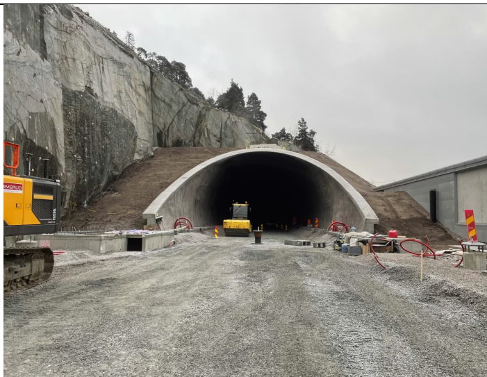
Bilde 4. Portal til Mossetunnelen ved Sandbukta. Tilbakefylling arbeid utført over portalen
