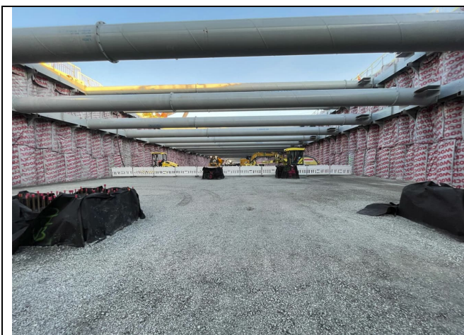
Bilde 14. Larkollveien kulvert. Gravearbeidet ble fullført
